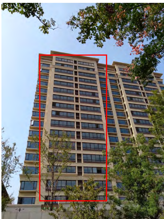
临近神山路一侧住宅楼双层玻璃
