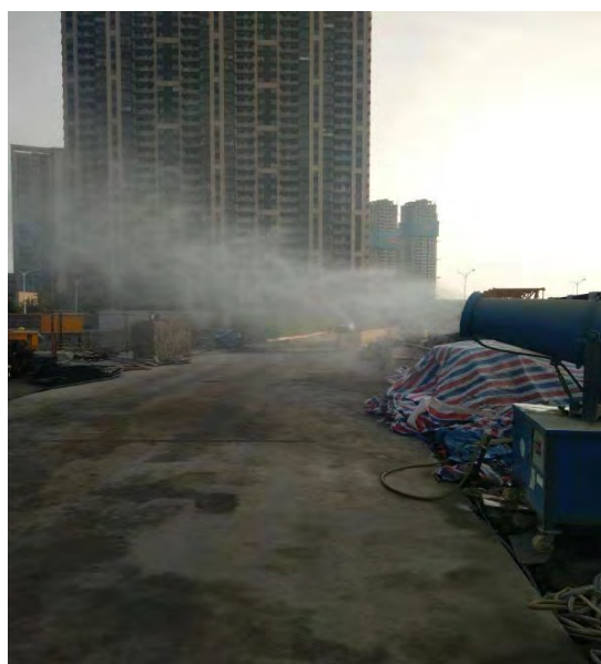
施工期雾炮开启防尘
