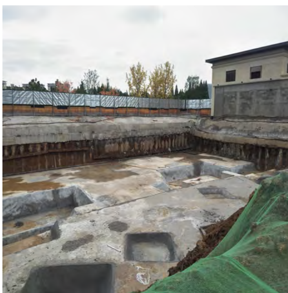
施工期裸露地面覆盖抑尘
