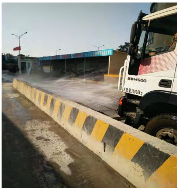
施工期车辆进出清洗
