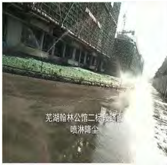
施工区道路喷淋降尘
