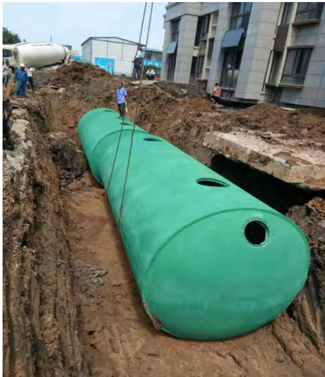
成品混凝土预制化粪池
