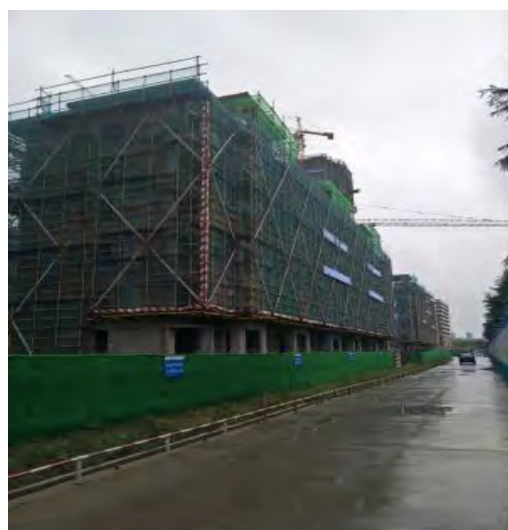
施工期工地外围围挡
