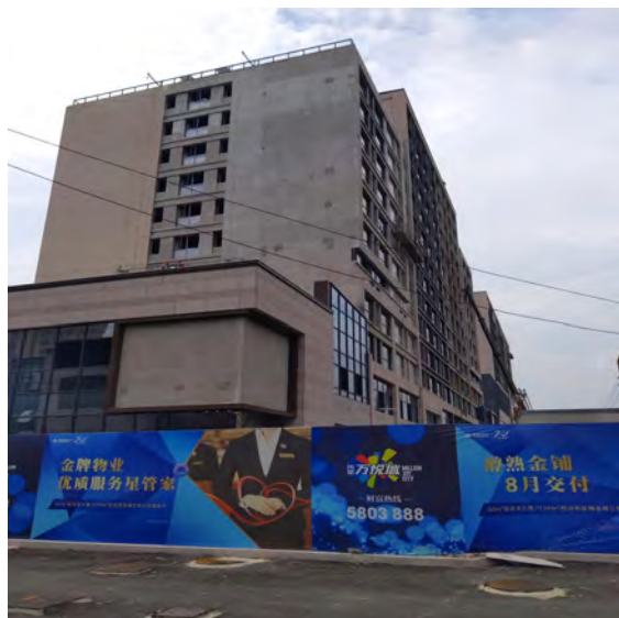
施工期场地四周挡板
