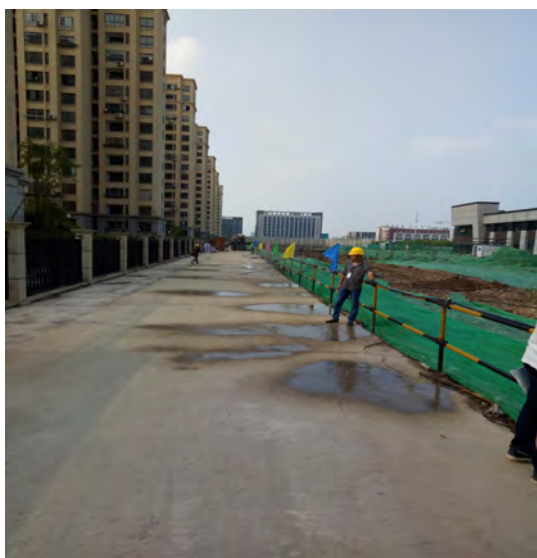
施工期裸露地面覆盖
