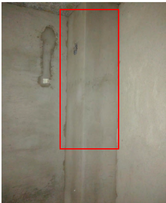
住宅楼油烟通道
