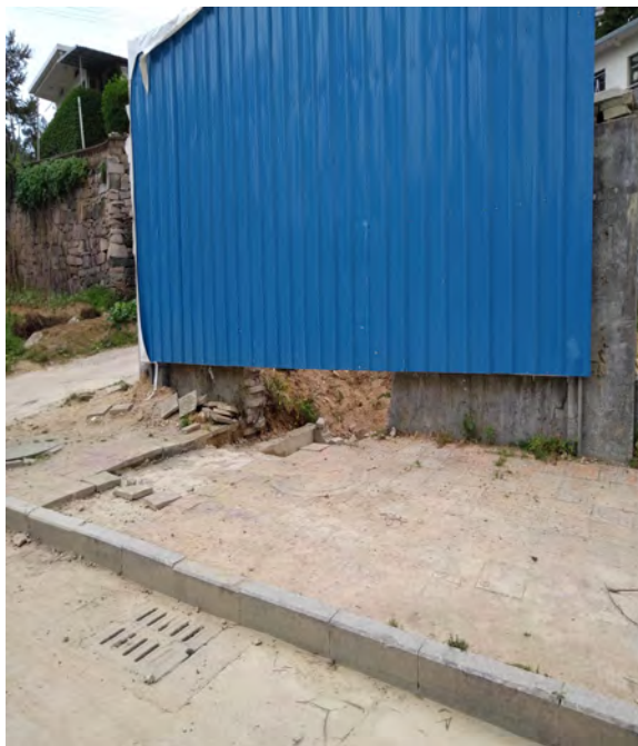
施工期场地四周围挡抑尘
