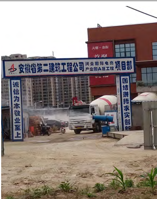
施工期雾炮开启抑尘
