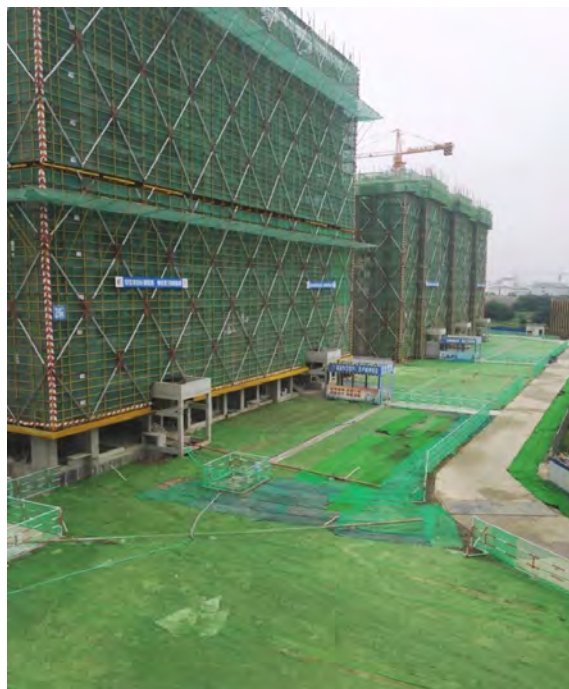
施工期裸露地面覆盖抑尘
