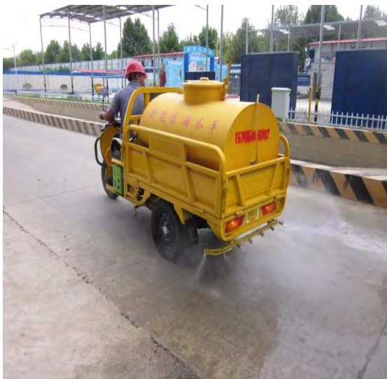
施工区道路扫水
