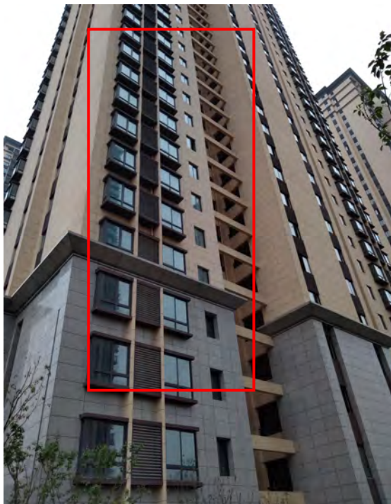
临近文昌路一侧住宅楼双层玻璃
