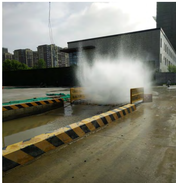
施工期进出车辆清洗
