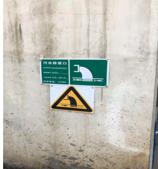
废水排放口标识
