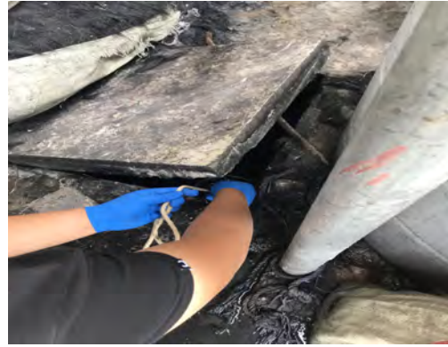
生产废水排口
