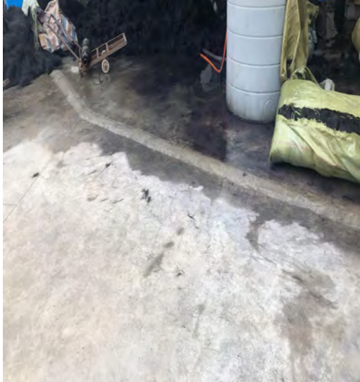
废水收集围堰
