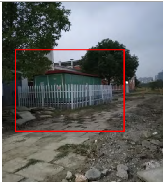
教学实验楼 C 座化粪池
