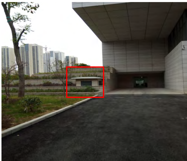
地下车库排风口
