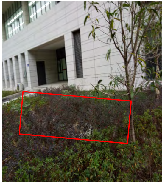
图书馆化粪池
