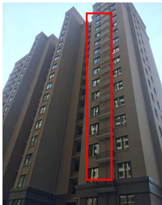
住宅楼雨水管道
