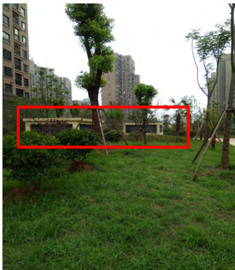
地下车库排风口
