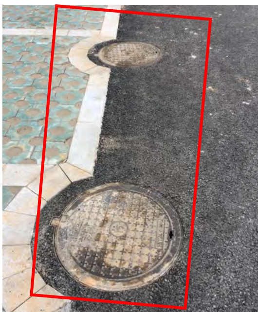
22#楼西侧化粪池
