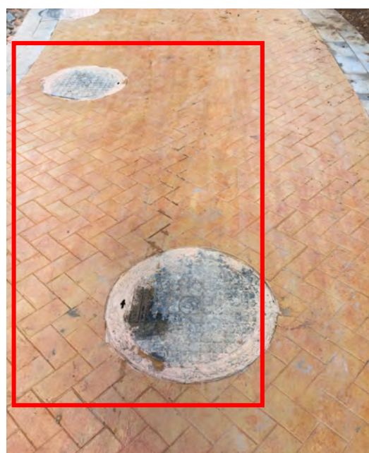
21#楼东侧化粪池
