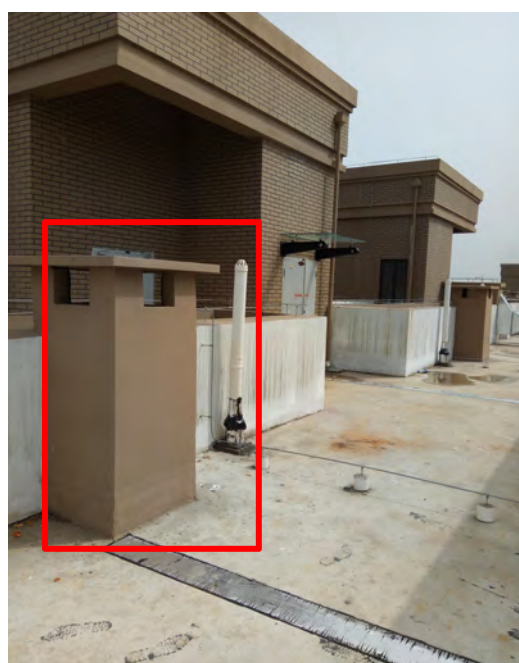
楼顶烟道排口
