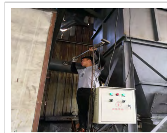
熔化炉废气进口 2
