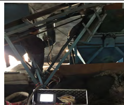
砂处理废气排气筒进口
