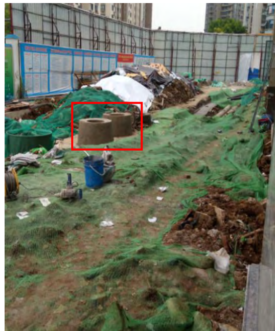
S05 南侧化粪池和隔油池
