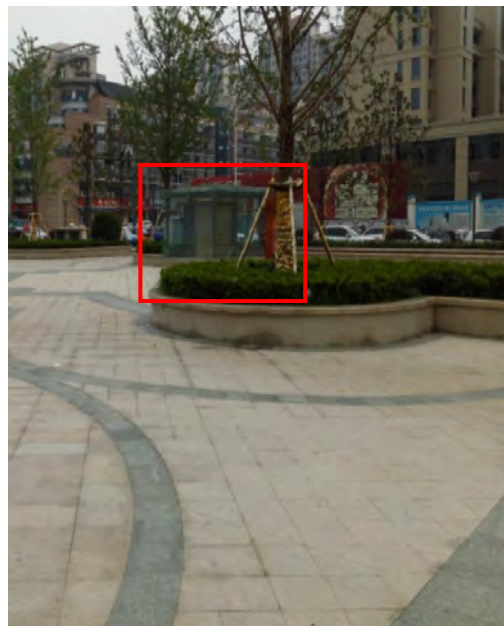
地下出库排风口
