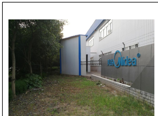
厂界冷却塔隔音罩（外）
