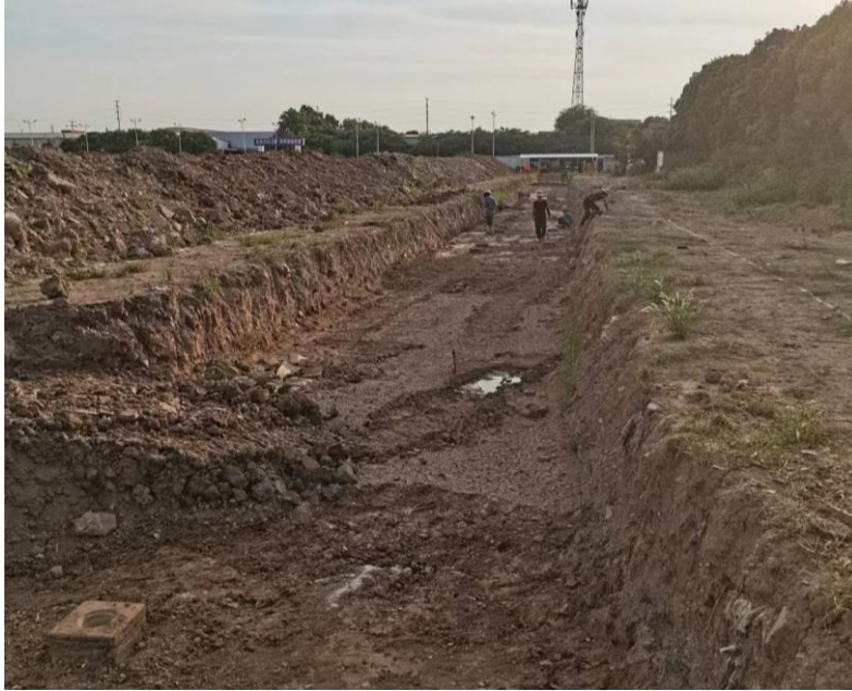
图 1-12 项目土方开挖临时堆土
