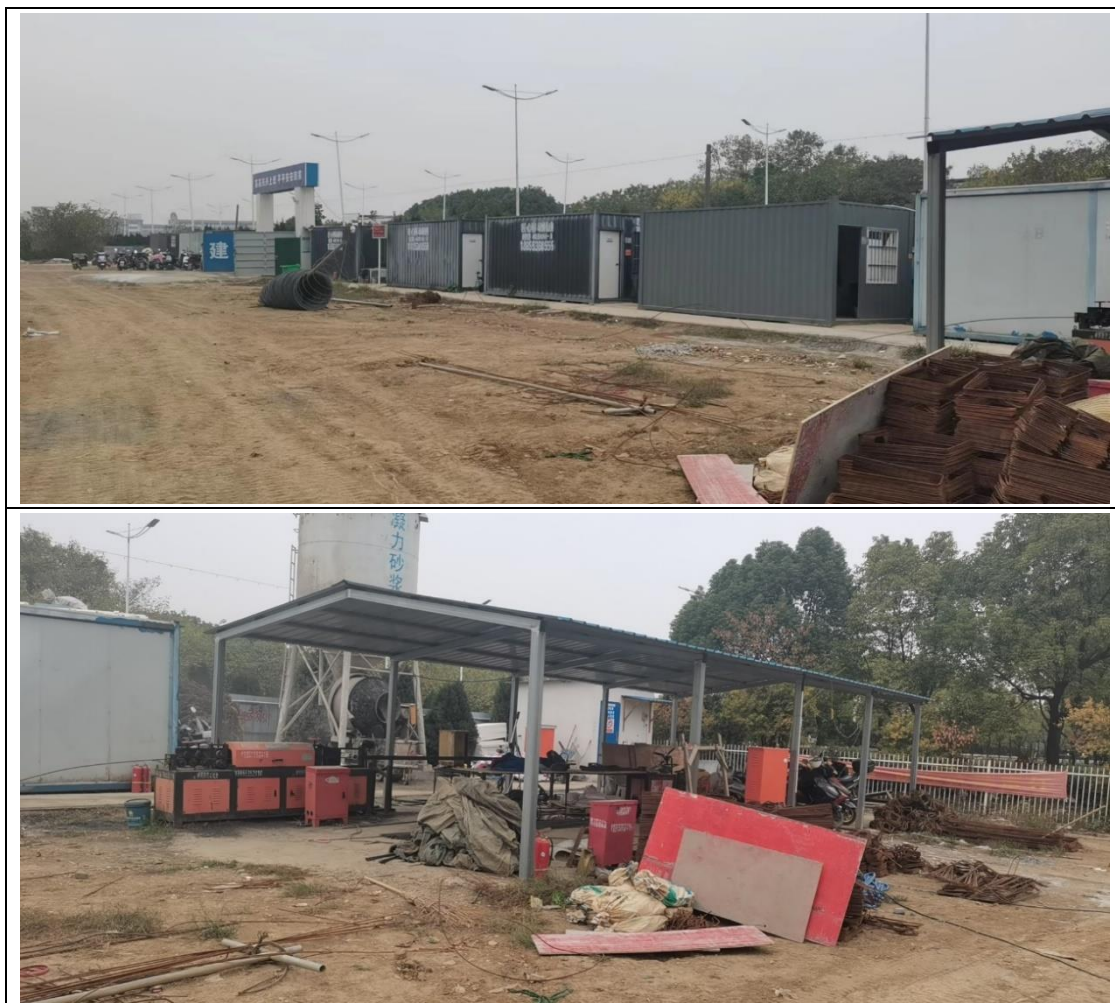
图 1-11 施工生产生活区现状图
