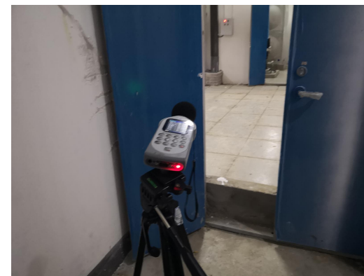
生活水泵房北侧噪声
