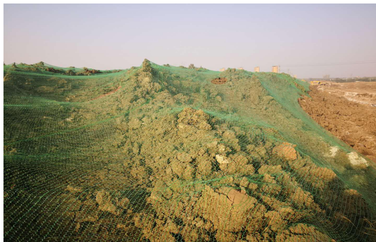
施工期裸露地面覆盖
