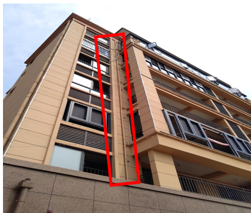
住宅楼排水管道
