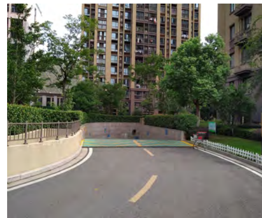
地下车库出入口
