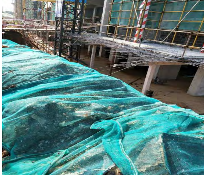
施工期裸露地面覆盖
