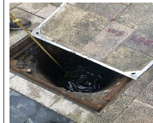
银湖北路废水排放口
